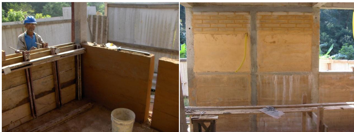
Figura 24. Execução de paredes maciças de solo-cimento moldadas in loco , na obra da Vila Bonfim.
