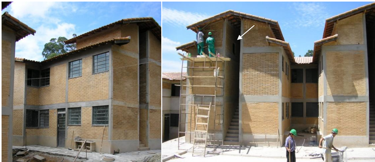
Figura 26. Janelas difíceis de limpar – basculantes e de correr com uma folha móvel, no pavimento superior, na Vila Bonfim. Figura 27. Acesso às caixas d’água. Fonte das imagens: arquivo Pró-Habituação.
