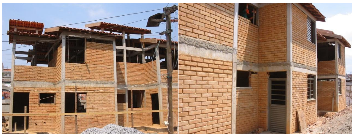
Figuras 22 e 23. Alteração do projeto dos vãos durante a execução da alvenaria. Fonte: arquivo Pró-Habitação.
