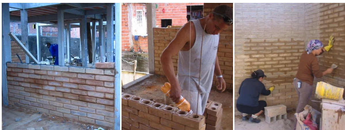
Figura 13. Alvenaria assentada com argamassa de solo-cimento, que já pode ser rejuntada ao mesmo tempo, evitando o trabalho extra no final da obra.
